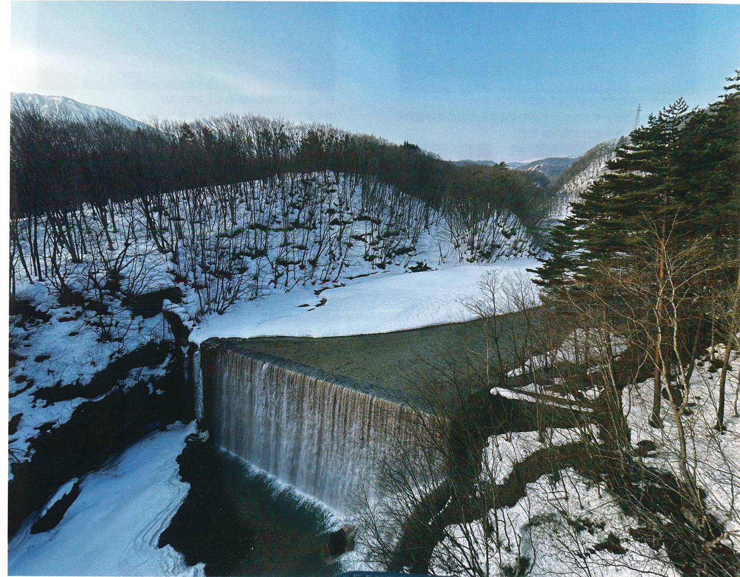
『森の大橋』上流側 2023/3/8
